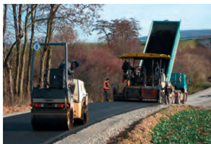
Asphaltfertiger im Einsatz bei Bad Langensalza. (Foto: VLF Thüringen)
