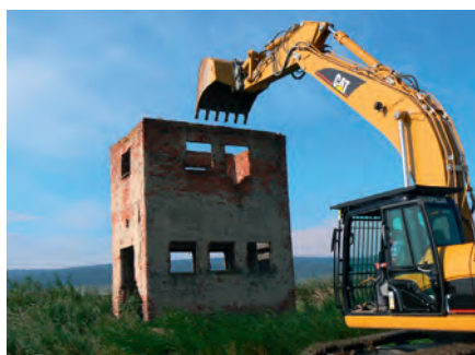
Abriss eines ehemaligen Vogelbeobachtungsturmes bei Esperstedt, Kyffhäuserkreis. (Foto:ThLG)
