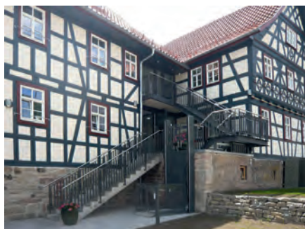
Saniertes Gebäude. (Foto: Arztpraxis Dr. Krampe)
