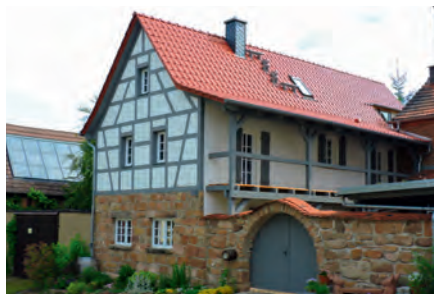
Sanierter Fachwerkhof in Hainbücht, Saale-Holzland-Kreis. (Foto: ALF Gera)
